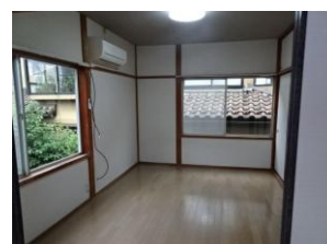
2階 洋室 エアコン
